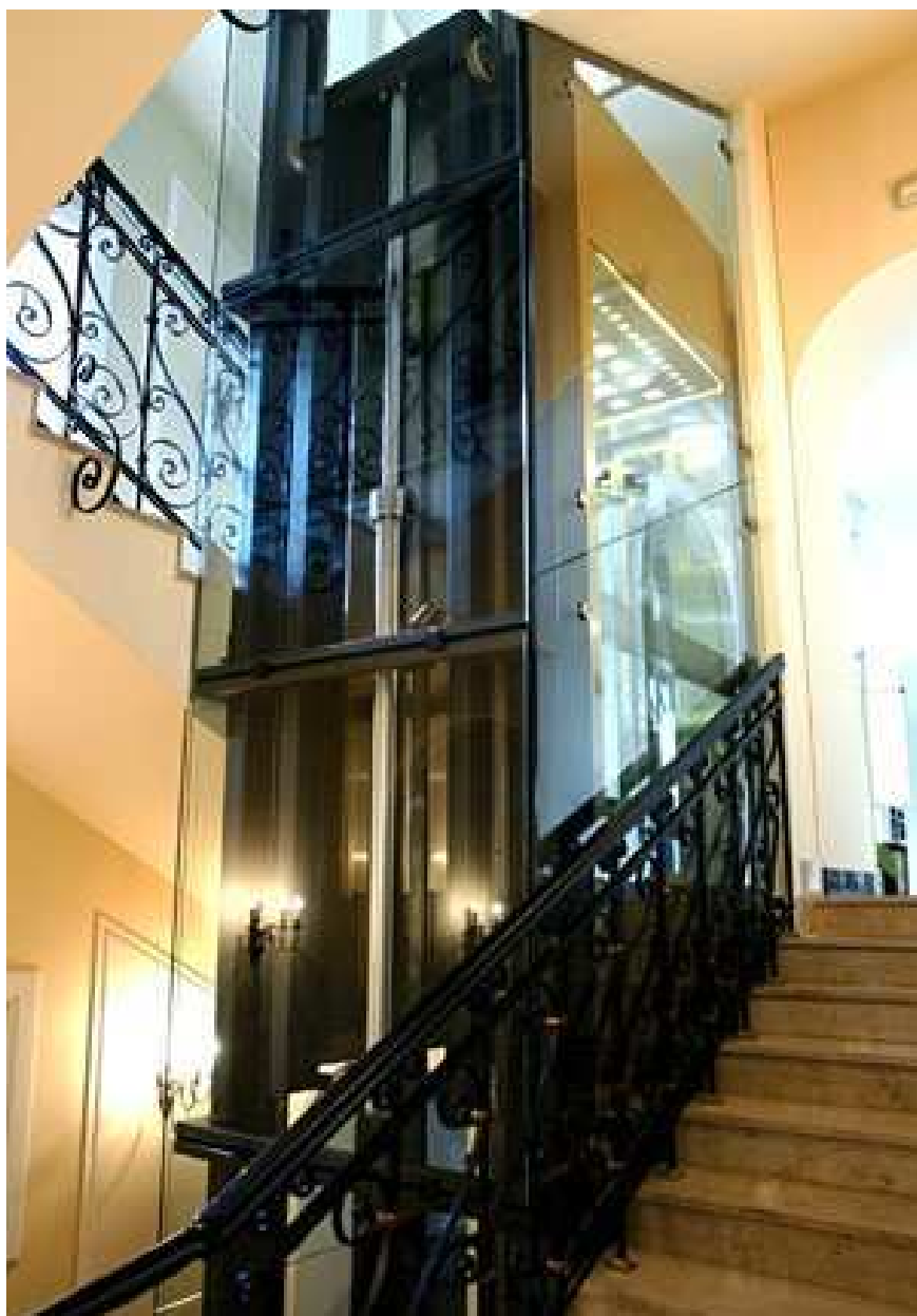
Na zdjęciu: Winda wbudowana w zabytkową klatkę schodową w budynku Komisji Sejmowych (bud. G). Fot.: Piotr Stanisławski
